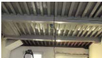
Spuiten van wanden en plafonds
