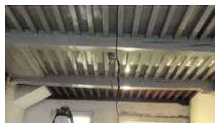
Spuiten van wanden en plafonds
